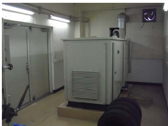
【非常用自家発電設備(高野山浄水場)】
