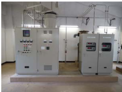
【高野山浄水場：オゾン処理設備】
