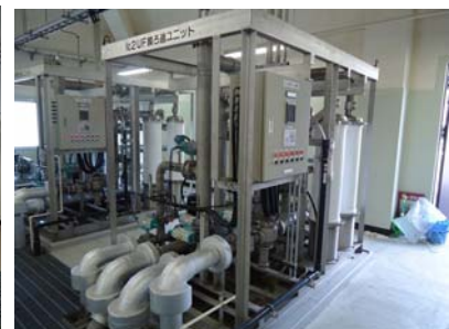
【富貴浄水場：膜ろ過設備】
