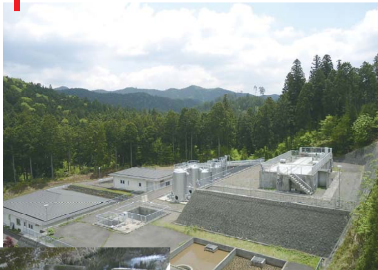
高野山浄水場
