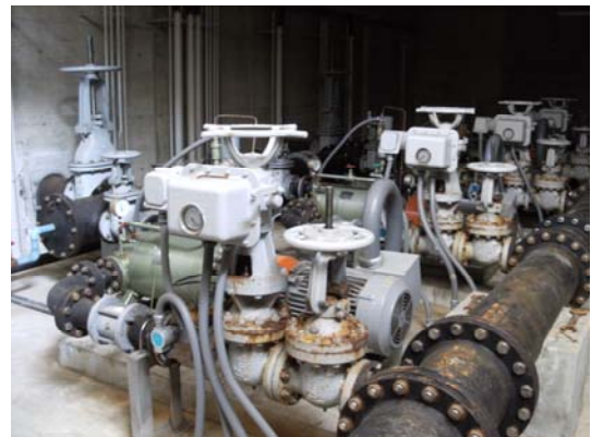
【送水ポンプ(高野山浄水場)】
