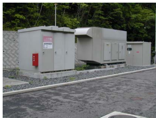
【非常用自家発電設備(相ノ浦浄水場)】
