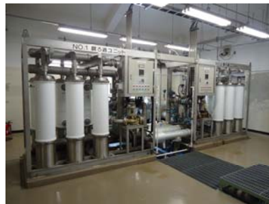
【相ノ原浄水場：膜ろ過設備】
