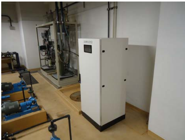
【魚類監視水槽(高野山浄水場)】
