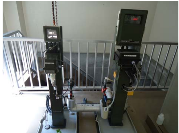
【水質自動計測装置(相ノ浦浄水場)】
