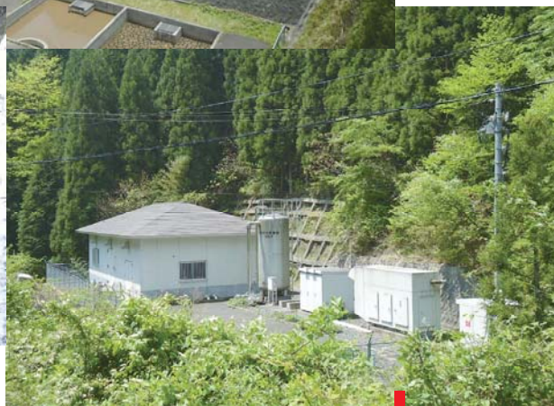
相ノ浦浄水場
