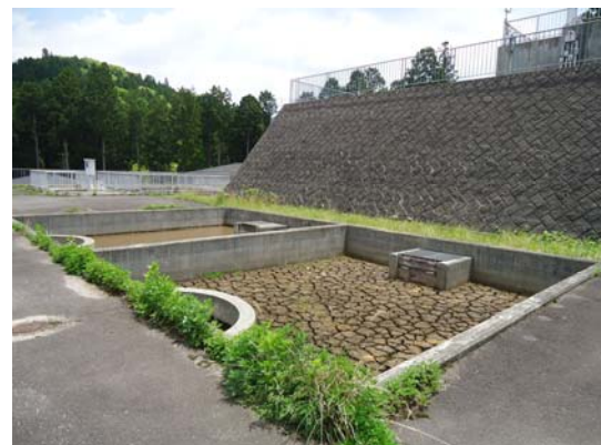
【天日乾燥床(高野山浄水場)】
