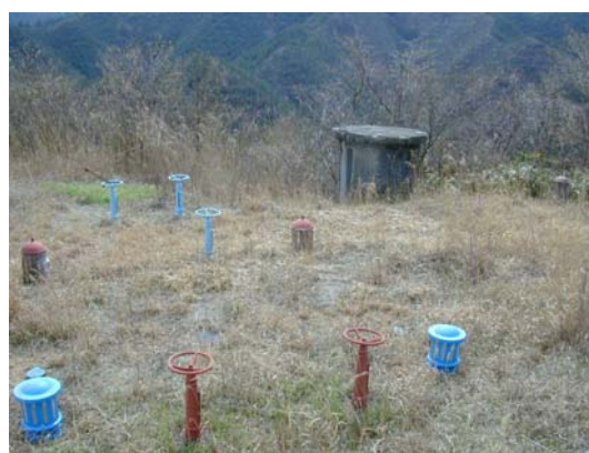
【相ノ浦配水池（地下）】
