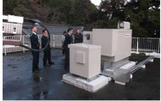
高野町消防本部(署)の屋上に設置された発電設備
