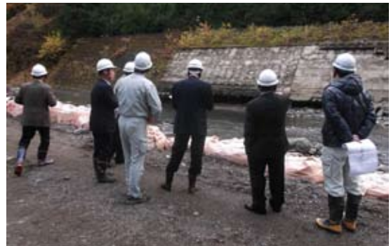
護岸被災状況確認 工事未着工部分
