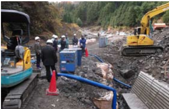
護岸復旧工事状況(工法確認) 進捗状況(工事費ベースで約10%)
