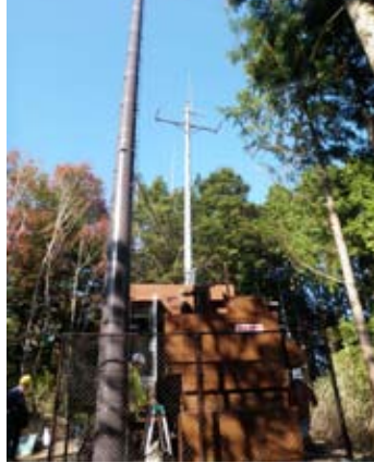
弁天岳に設置された無線中継局
