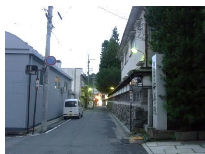
電線類、街灯（町道弁天通り）
