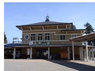
南海電気鉄道鋼索線 高野山駅駅舎
