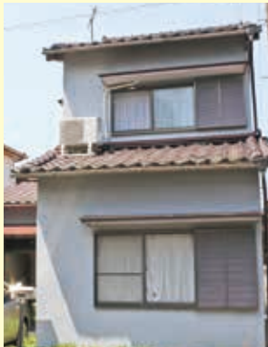
屋根葺き替え前
