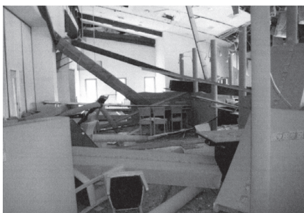
2階の天井部分が落下し、被災した「道の駅おおさと」
