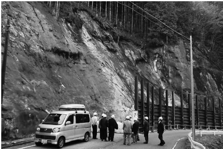
光の滝付近の土砂崩壊
