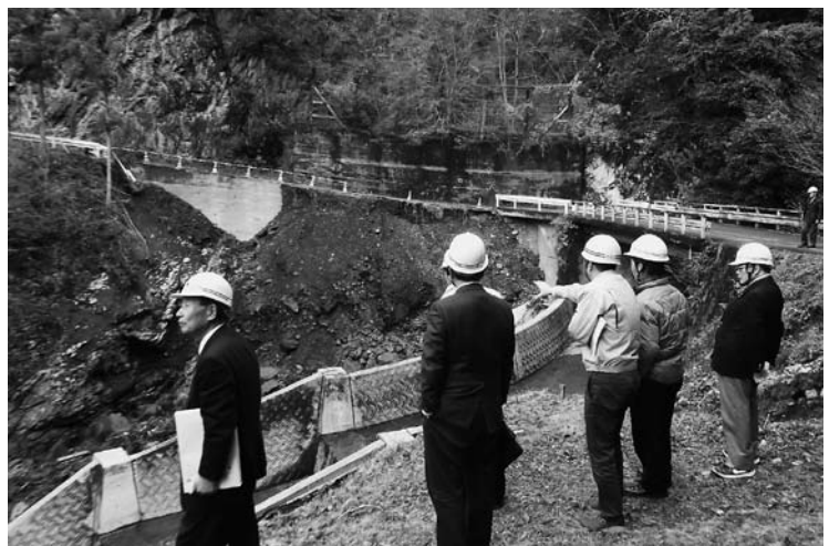
大滝地区河川の法面崩壊
