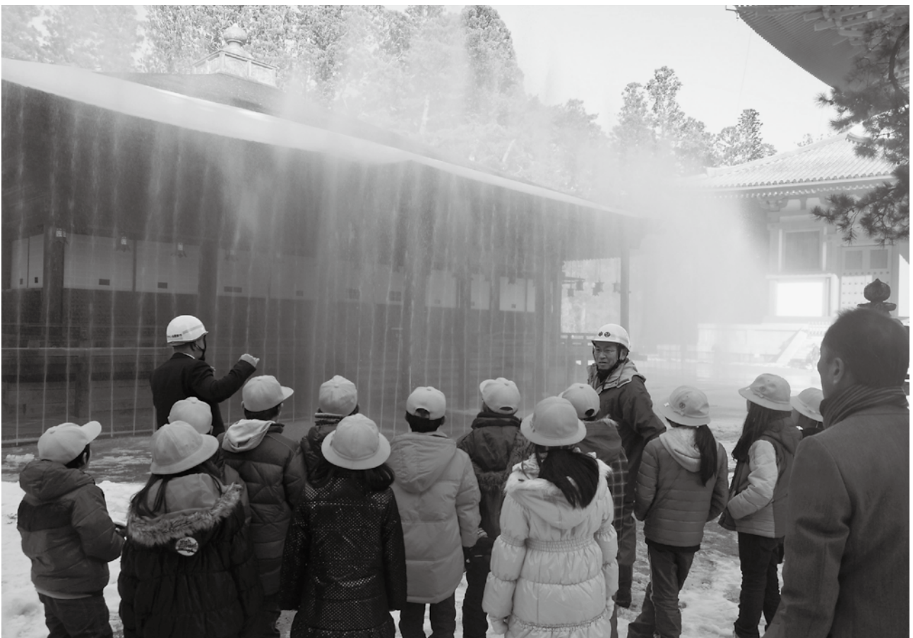
御影堂吹き上げ式ドレンチャー作動訓練・文化財防火デーにおいて
