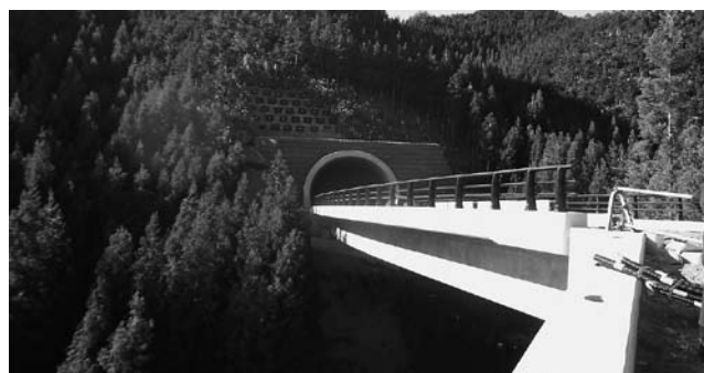
覚海トンネル・相ノ浦橋(国道371号交差点付近)
