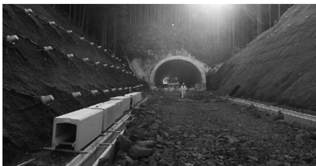
(千本榎トンネル付近)
