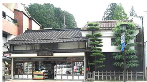
虎屋薬局 (H21.3.16 指定景観重要建造物)
