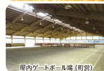
屋内ゲートボール場(町営)
