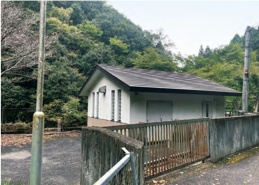
不動谷浄化センター
