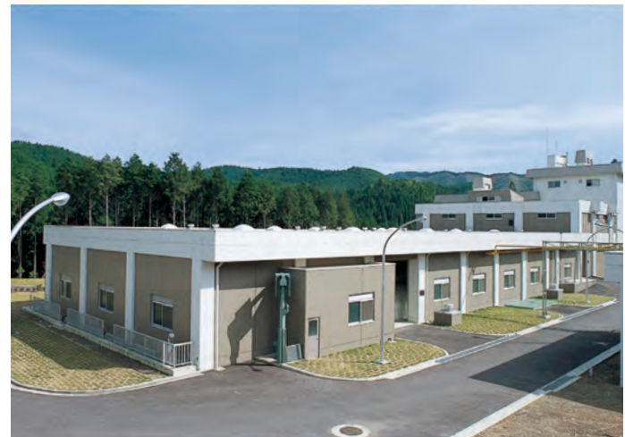
高野山下水処理場
