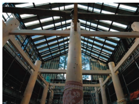
高野六木制度で育成したヒノキによる18本の心柱
