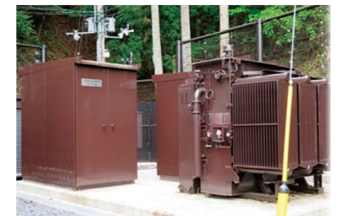
高野山配電塔
