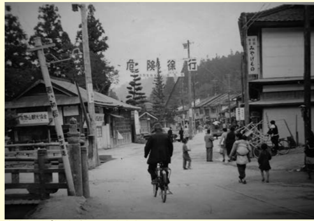
千手院橋交差点 (昭和32年)
