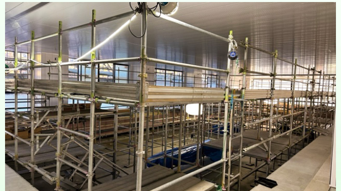
1階プール工事状況
