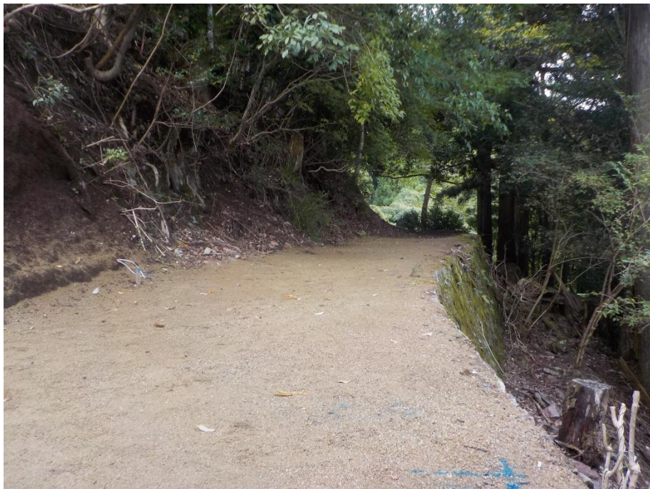
町石道復旧完了状況
