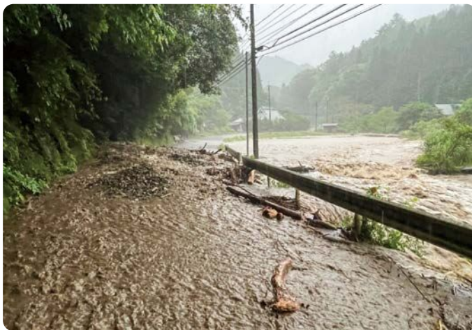
花坂地内を流れる川が増水し道路に越水した様子 ▲
